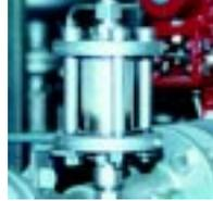
Eine einfache Rückschlagklappe verhindert den Kavitationsschlag. Im Moment der Strömungsumkehr, fällt die Klappe und schließt die Vakuumblase ein. Anschließend muss die Blase nur noch langsam aufgefüllt werden.
