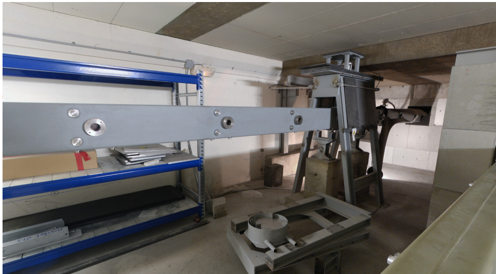
Abbildung 3.3.1: Neutronenleiter H113, wie er in das Strahlrohr mündet bevor dieses die Neutronen in den Bunker des Versuchsplatzes PF1B weiterleitet. 5
