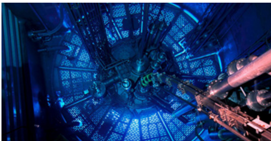
Abbildung 3.1.1: Blick in das Reaktorbecken. Unterhalb der durchlöchernten Stahlplatten befindet sich der Reaktorkern. Das bläuliche Licht ist Cherenkov-Strahlung, welche entsteht wenn Elektronen mit Überlichtgeschwindigkeit im Wasser abgebremst werden. 1
