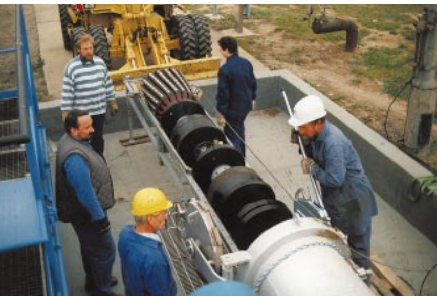
Abb. 2 Einschleusen des Molches in eine Pipeline Foto: Dittes
